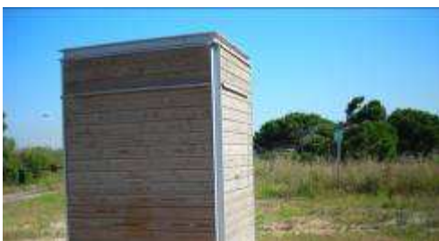
PUNT D'INFORMACIÓ ENTRADA DE LA CARRETERA DE LA VIDALA. ESPAI NATURAL DEL REMOLAR-FILIPINES
