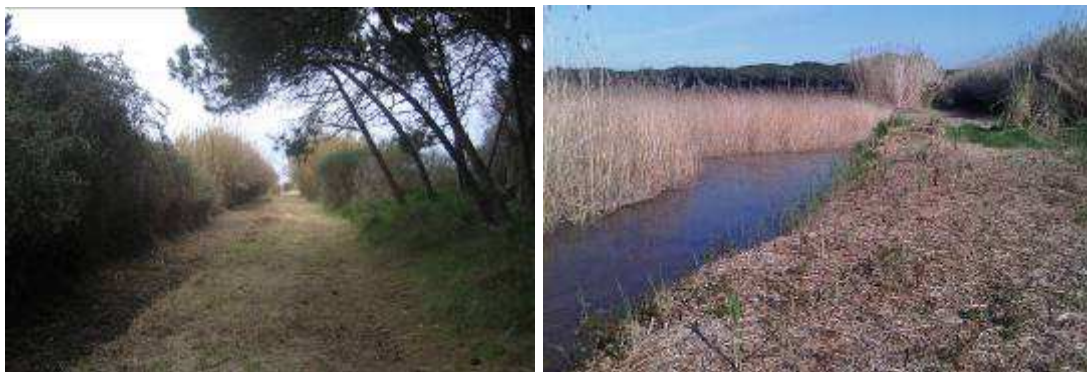
Tasques de neteja per a recuperar antics canals que inundaven el canyissar i canyissar de ca l'Arana inundat una vegada recuperat el canal.
