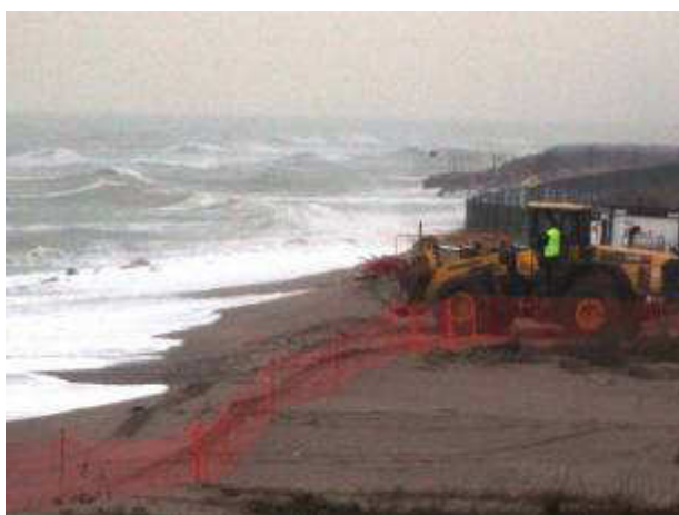
Imatge de les obres, amb l'onatge trencant contra les roques que protegeixen la canonada de la dessalinitzadora. Març.
