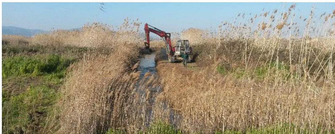
Retro giratòria realitzant el dragat de fangs de la llera d'una corredora
