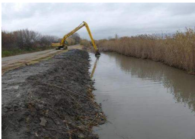
Màquina giratòria dragant els fangs del fons del canal de la Bunyola
