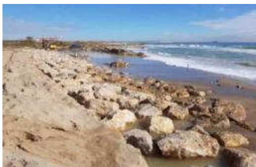
Fonaments de l'escullera col·locada entre Carrabiners i Bunyola. Octubre 2018
