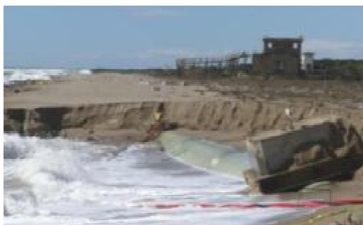
Canonada al descobert en la part que encara no tenia escullera. Edifici del Semàfor al fons. Març 2018
