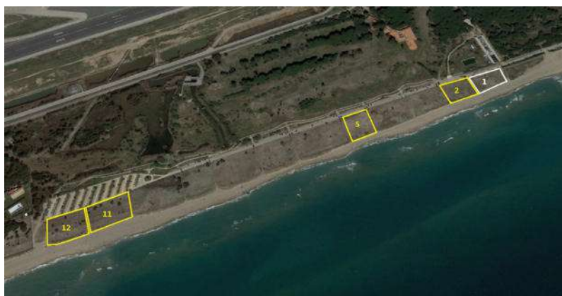
Parcel·les tancades amb palissada de fusta a la platja de la Roberta
