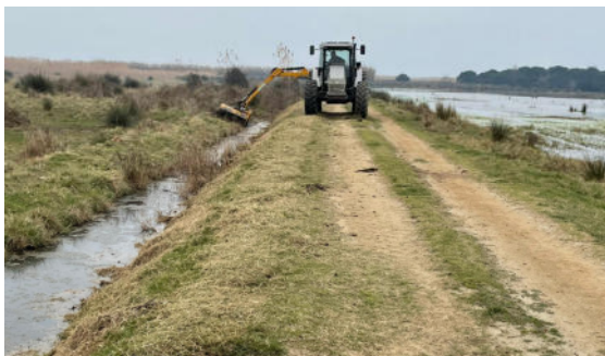
Neteja canal d'inundació. Prats de cal Tet.
